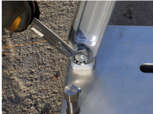
g. Spænd den nederste bolt på bagstøtten.
